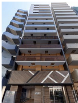
(17) 日本橋箱崎町 2 プロジェクト
