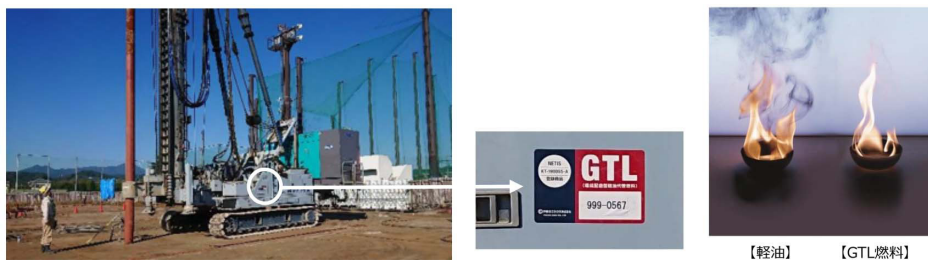
GTL 燃料（現場施工例：左／軽油・GTL 燃料：右）
