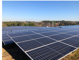
「リソルの森発電設備 (1.5MW)」
