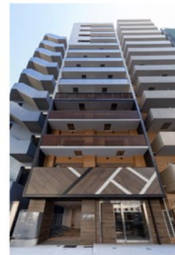
(17) 日本橋箱崎町2プロジェクト
