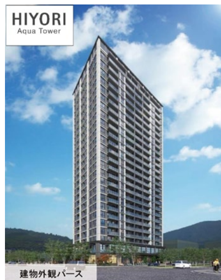
「HIYORI Aqua Tower」建物外観パース
