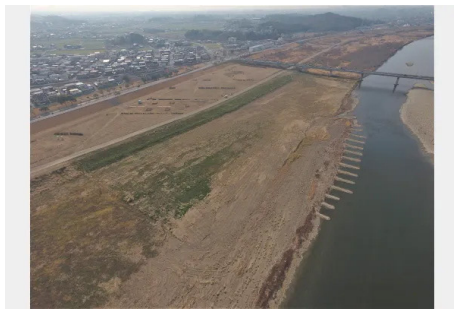
兵庫県 加古川下流部堆砂撤去工事
