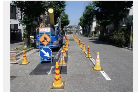
兵庫県内 開削工事
