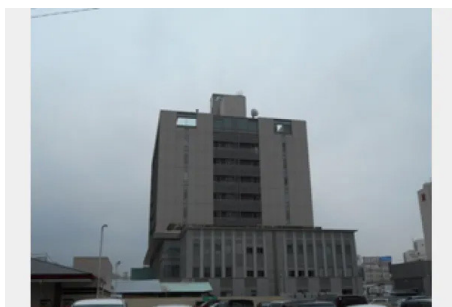
東播磨生活創造センター空気調和設備工事
