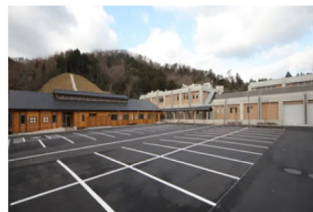
姫路家畜保健衛生所機械設備工事
