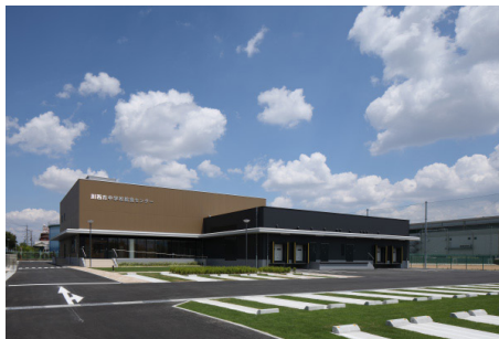
兵庫県 川西市中学校給食センター
