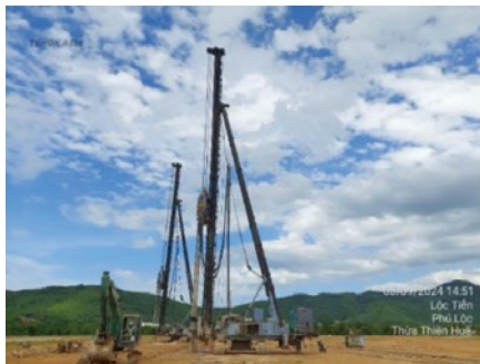
ベトナム自社施工第 1 号案件・大型自動車工場
