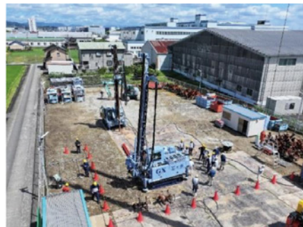
電動杭打機の成功試験
