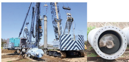
CP-X工法 (実験工事)
