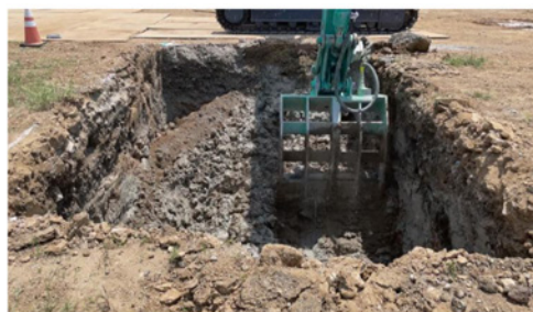
テノキューブ工法 (施工中)
