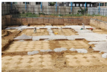
テノコラム工法 (施工中)
