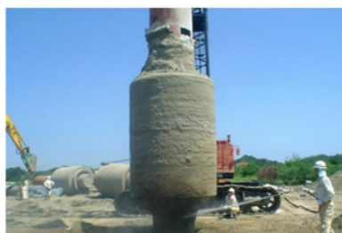
TN-X工法 (先端拡大根固め)
